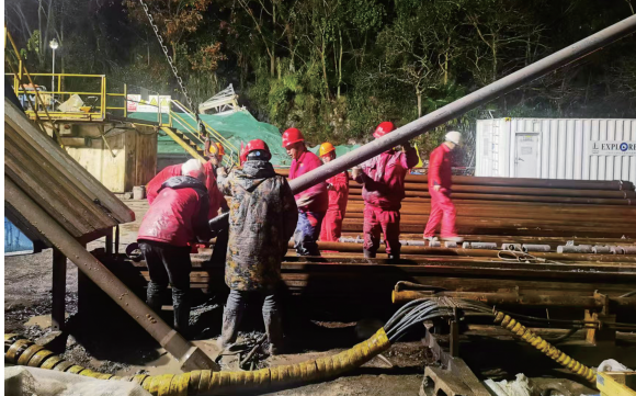
112地质大队黔西南打屋坝组页岩气探井钻完井技术服务钻井工程现场
