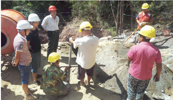
安全生产地矿行——115地质队贯彻“四不两直”工作制度赴云南永仁县检查泥石流治理工程检查。
