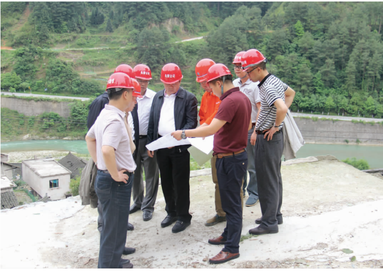
局长、局党委书记付贵林(中)带队下基层开展安全检查,强调要进一步强化安全意识,层层落实安全责任,加大施工安全的监督检查力度,确保安全生产、安全发展。
