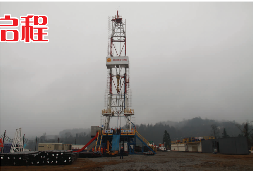
ZJ20/1350DB型变频电驱动钻机是贵州省首台,钻机设计施工能力3000米,自升式井架高33米,适用于地热、页岩气、煤层气井的钻探施工。
